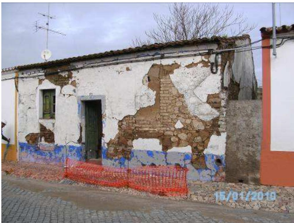
v) Colapso dos apoios da cobertura e respectivo telhado o que potencia a degradação das alvenarias e afecta a edificação vizinha a Norte.
