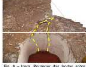
Fig. 8 - Idem. Pormenor das fendas sobre a porta de entrada.
