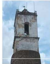
Fig. 1 - Alçado principal. Vista geral.
