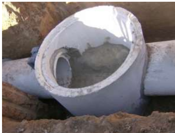
Ligação de caixa de visita com a rede de águas pluviais DN1000
