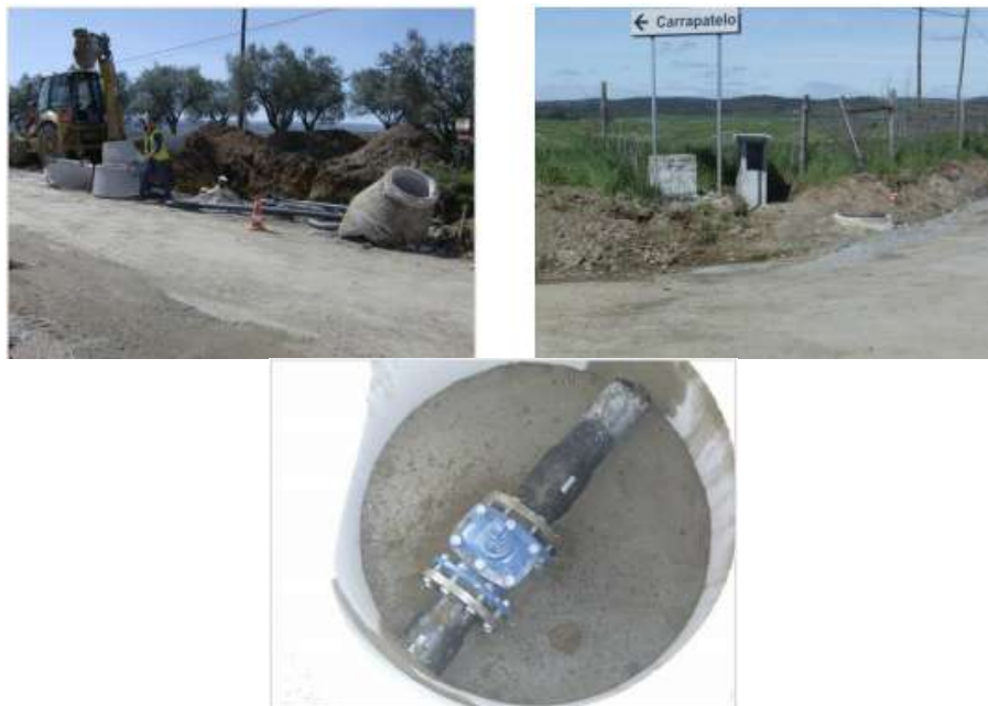
Ilustração 30. Troço São Pedro do Corval/St.º António do Baldio - obras
