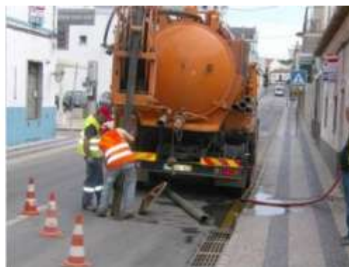
Ilustração 35. Limpeza dos Coletores de Esgotos Domésticos no Concelho de Reguengos de Monsaraz
