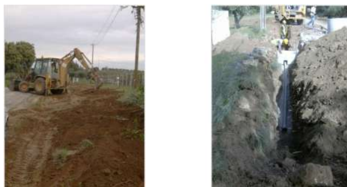
Ilustração 31. Troço Carrapatelo - obras
