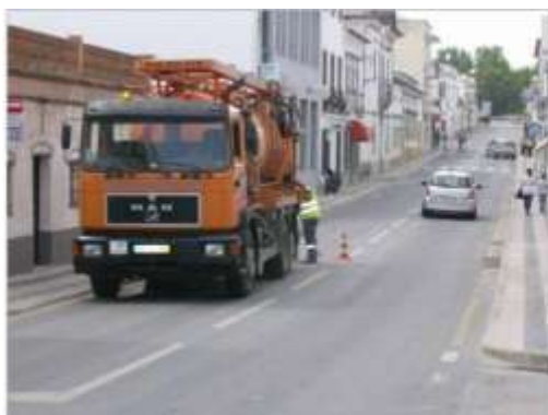
Ilustração 35. Limpeza dos Coletores de Esgotos Domésticos no Concelho de Reguengos de Monsaraz
